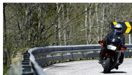
Sving med rekkverk med underskinne
